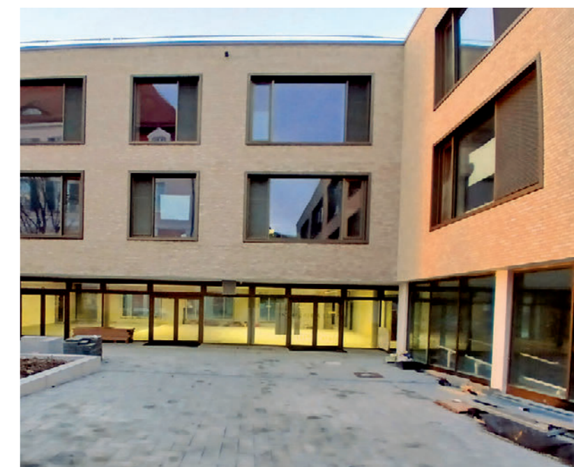
Der Innenhof ist gepflastert und schon weitgehend fertiggestellt.
