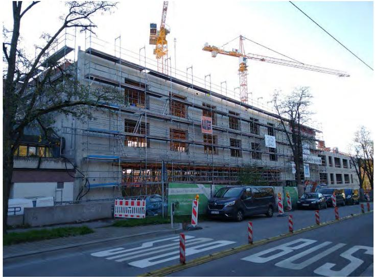
Im Dezember 2022 ist der Rohbau fast fertiggestellt. Nun beginnt der Bau der Hülle, mit den Arbeiten zu Fenstern, Dämmung und Dachabdichtung. Auch die Innenausbauten starten in der nächsten Zeit.
